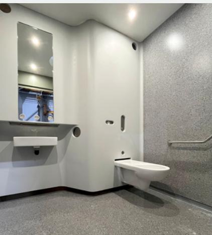
Cuvette et lave-mains en céramique ou inox - Cloison de fond surélevée - Sol en béton poli anti-dérapant avec buses de lavage haute pression
