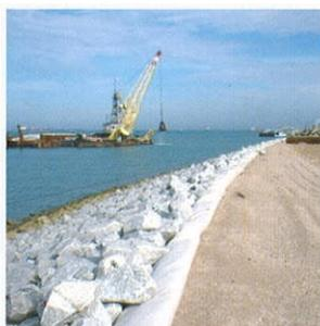
■ Les forces de la marée peuvent causer des dégâts importants aux digues et aux constructions en pleine mer. Des constructions pour protéger ces structures sont réalisées en employant des géotextiles filtrants entre le sol et les enrochements de manière à éviter une érosion du sol.
