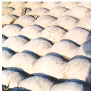
■ L'installation d'une protection de talus au moyen d'éléments préfabriqués en béton, est une opération qui prend du temps et qui est chère, (certainement sous eau).
