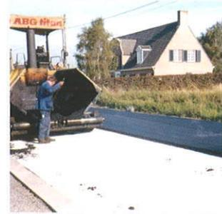
■ Au bout d'un certain temps, la surface des routes avec un revêtement à liants hydrocarbonés montre des fissures. Les réparations nécessaires s'imposent pour pouvoir prolonger la durée de vie de la route. L'application d'une nouvelle couche supérieure, ce qui est une solution économique, contient le risque que les fissures de la couche inférieure soient présentes dans cette nouvelle couche...
