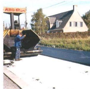
■ Au bout d'un certain temps, la surface des routes avec un revêtement à liants hydrocarbonés montre des fissures. Les réparations nécessaires s'imposent pour pouvoir prolonger la durée de vie de la route. L'application d'une nouvelle couche supérieure, ce qui est une solution économique, contient le risque que les fissures de la couche inférieure soient présentes dans cette nouvelle couche...
