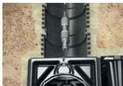
Une caméra d'inspection permet d'inspecter très facilement l'unité globale de rétention et d'infiltration via le puits d'inspection.
