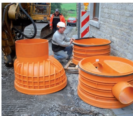
→ Un chantier où l'étanchéité devait être particulièrement soignée avec la pose des éléments Rehau en PP.
